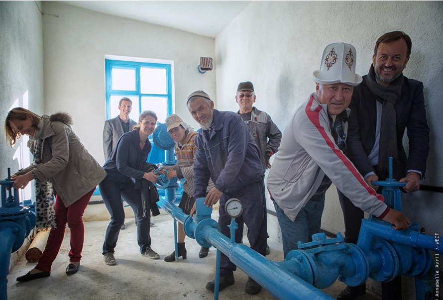
WECF France était présente lors de l'inauguration de la réhabilitation de l'accès à l'eau à An Oston (Kirghizistan) en avril © Annabelle Avril - WECF
